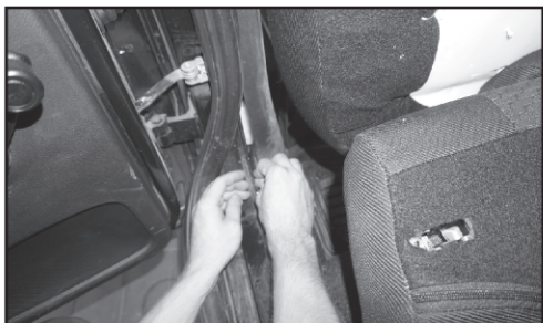
11. Вытаскиваем провода в гофре и зачищаем их.
