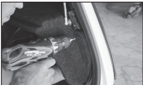
15. Прикручиваем боковину к кузову саморезами по металлу (3,5x32 мм).
